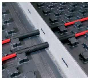
Obr. 92 Průchod přes dilatační profil
