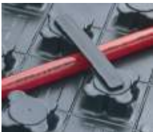
5. Dle potřeby zafixovat trubku upevňovací skobou
