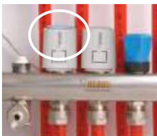
3. Na adaptér navčakneme termopohon.
