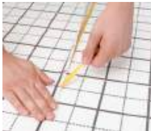
2. Slepění přesahů pokládací desky Tacker
