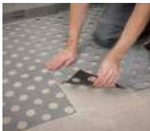
8. Další rohož přilepte bez překrytí
