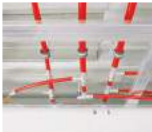
Obr. 84 Připojovací potrubí Tichelmann
