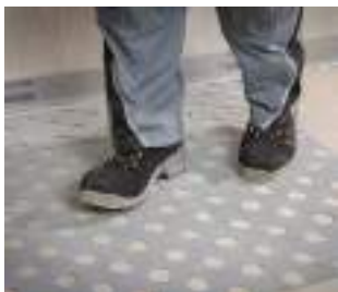
7. Na celé ploše přitlačte na podklad
