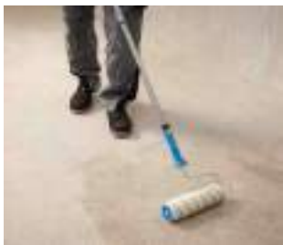
1. Natření podkladu vhodnou penetrací
