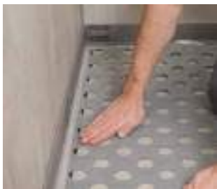
5. Přilepte část rohože na poklad
