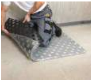
4. Ze spodní části odlepte ochranou folii
