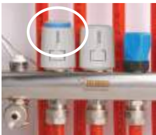
1. Termopohon otevřený
