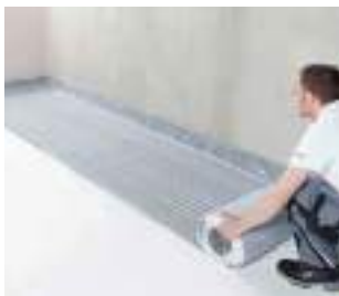
2b. Postupné přilepení rohože - role
