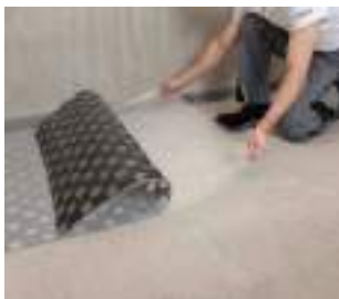
6. Odstraňte zbytek ochranné folie
