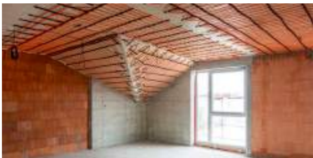
Obr. 78 Stropní vytápění/chlazení - mokrý způsob
