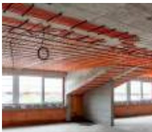
Obr. 75 Stropní vytápění/chlazení – mokrý způsob
