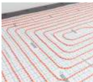
7. Hotová pokládka, proveďte tlakovou zkoušku
