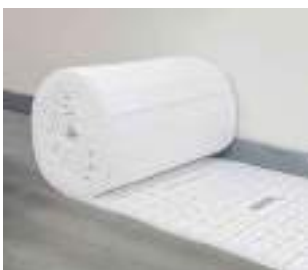
2. Položte pokládací roli rozvinutím
