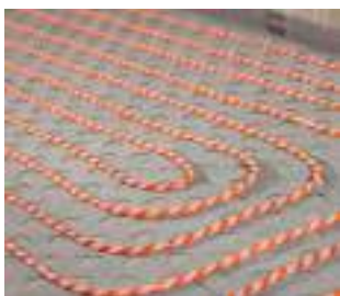
11. Hotová pokládka, proveďte tlakovou zkoušku
