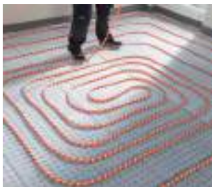
6a. Pokládka trubek na rohož
