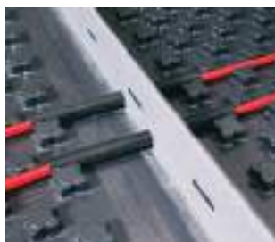
Obr. 92 Průchod přes dilatační profil
