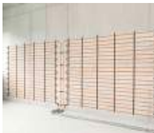
Obr. 64 Stěnové vytápění, jednoduchý meandr
