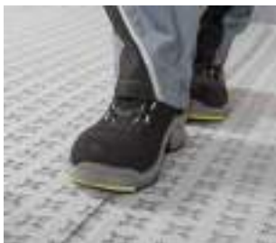
4. Přitlačte pevně přesahy rohože
