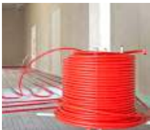
3. Pokládka trubky z odvíjecího zařízení
