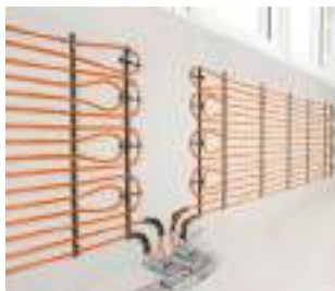
Obr. 65 Stěnové vytápění, jednoduchý meandr
