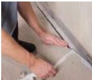
3. Přilepení folie patky dilatační pásky
