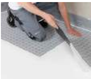
2a. Postupné přilepení rohože - deska
