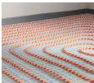
7. Hotová pokládka, proveďte tlakovou zkoušku
