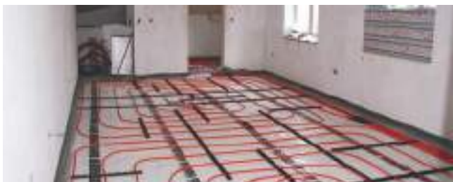
Obr. 28 Systém RAUFIX
