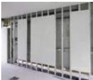
Obr. 68 Stěnové vytápění/chlazení – suchý způsob
