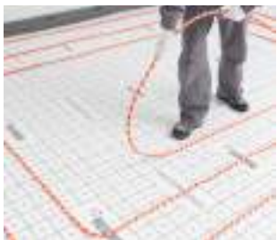
6a. Pokládka trubky RAUTHERM SPEED K
