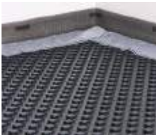
1. Pokládka systémové desky Varionova
