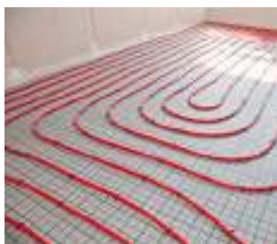
6. Hotová pokládka podlahového vytápění
