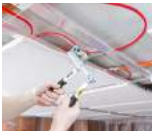
Obr. 83 Montáž připojovacího potrubí
