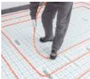
6b. Pokládka trubky RAUTHERM SPEED K
