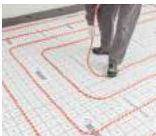
6c. Pokládka trubky RAUTHERM SPEED K
