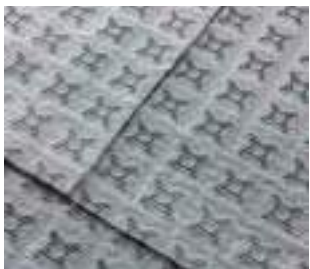
5. Položte rohože tak, aby vytvořily „T-spoj“
