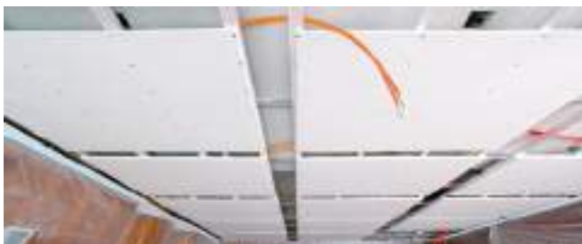
Obr. 82 Stropní vytápění/chlazení - suchý způsob
