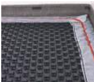
2. Pokládka trubky RAUTHERM S u stěny
