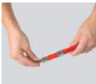
4. Vložení fitinku do trubky až na poslední žebrový výstupek.
