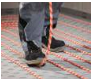
9. Pokládka trubky RAUTHERM SPEED K 10
